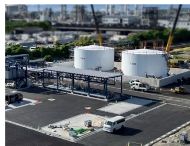
SAF原料となる廃食用油受け入れ施設 (コスモ石油製油所構内)
