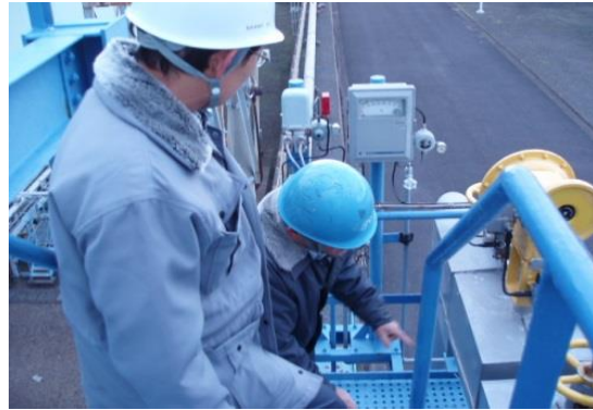
受払配管満液確認
