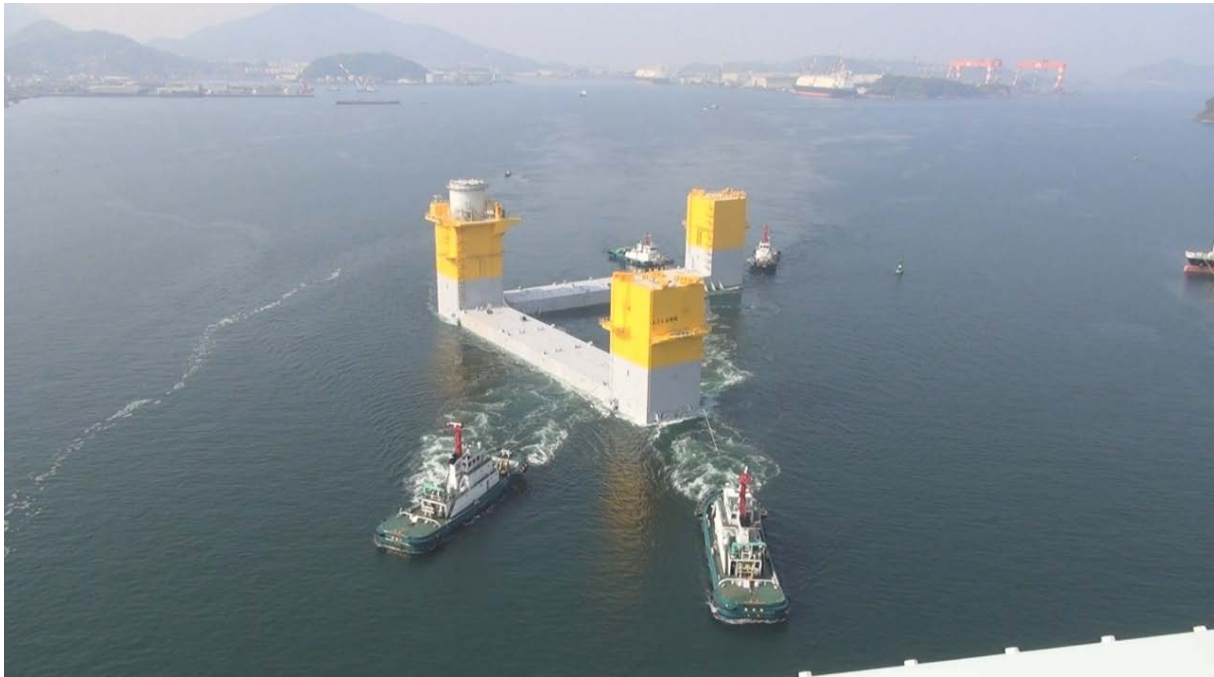
長崎港内を曳航される7MW油圧ドライブ型浮体式洋上風力発電設備用浮体
