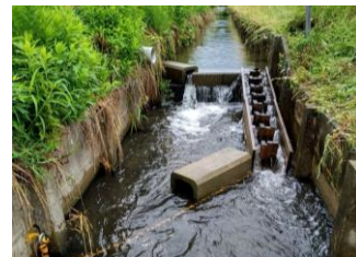
現地水路に設置した魚道
