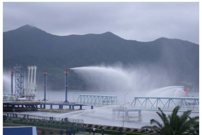
船舶火災消火訓練 一斉放水
