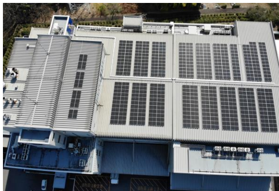
設置した太陽光パネル
