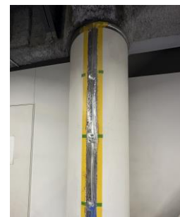
ひずみセンサ 取付状況（柱部分）
