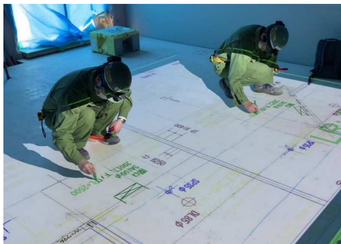
写真 3 墨出し作業状況
