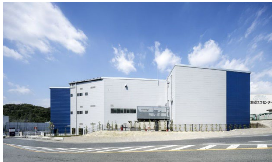
「京田辺ロジスティクスセンター」外観
