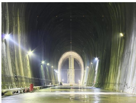
倉敷国家石油ガス備蓄基地 No.1 プロパン貯槽(高さ 24m 幅 18m)
