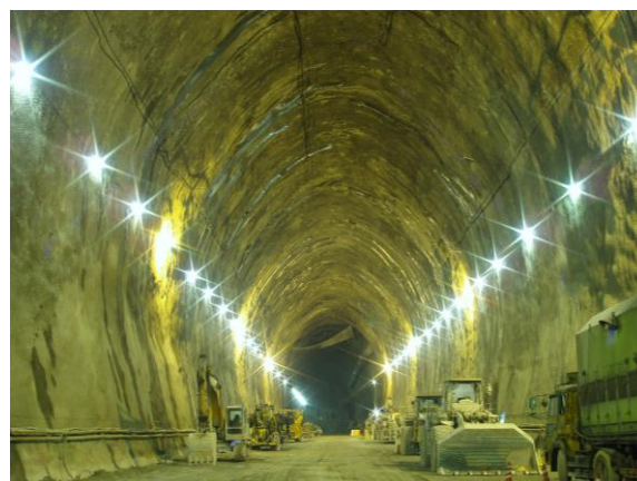
波方国家石油ガス備蓄基地 No.2 プロパン貯槽(高さ 30m 幅 26m)
