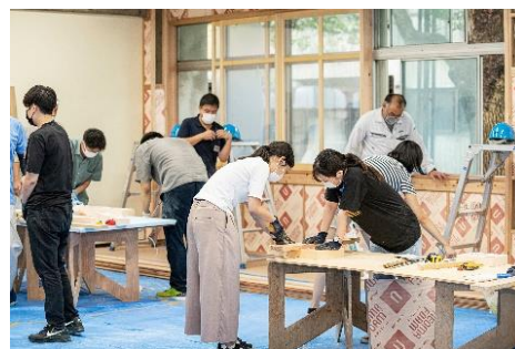
改修工事の様子
