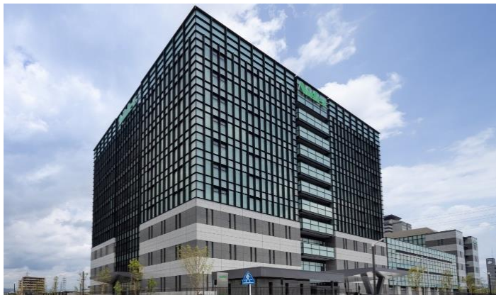
中央開発技術研究所 (ニデックパーク C 棟)
