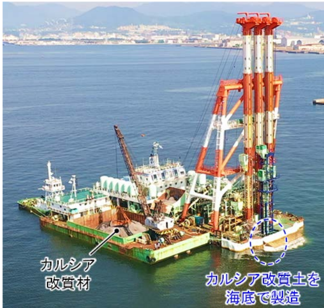
【図1】 バッチ式原位置混合工法の実海域での施工試験
