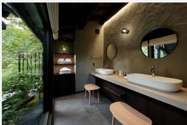
地元の土を使った土壁でつつみ込む、開放的な洗面スペース
