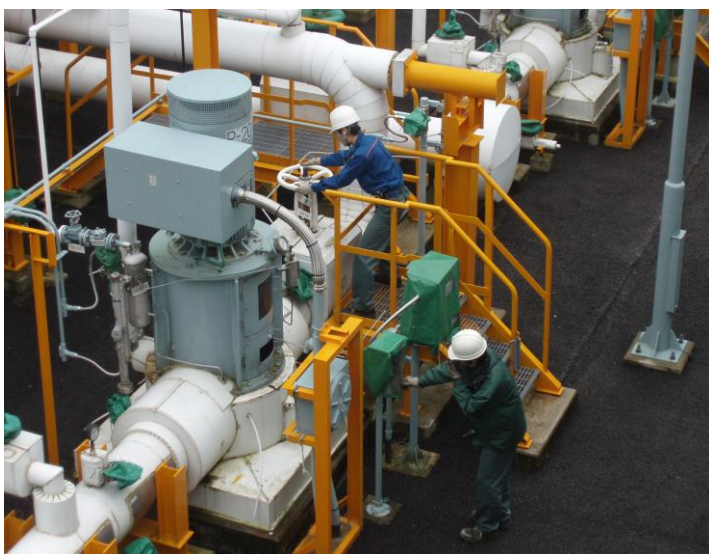
現場安全等確認作業
