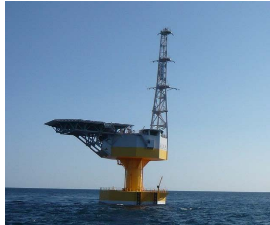
66kV 浮体式洋上サブステーション「ふくしま絆」 (浮体形式：アドバンストスパー)
