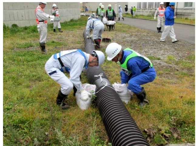
導水配管接続(実地訓練)
