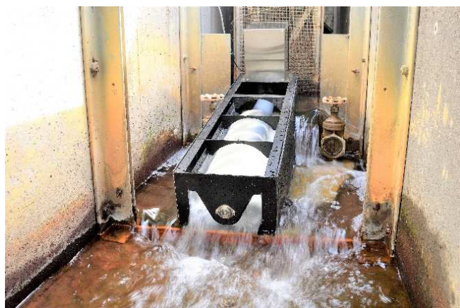
(左)リコー沼津事業所に設置したピコ水力発電装置 (右)イベントで活用するピコ水力発電装置
