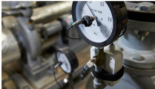
工場のガスメータをはじめとしたアナログメータの遠隔モニタリングシステムです。磁気センサーで指針の動きを計測し、Bluetooth®やLPWA (Low Power Wide Area) などの無線通信技術を用いてデータをクラウドに送信。クラウド上で指針の角度算出を行い、独自のアプリケーションでメータ値をリアルタイムに一括確認することができます。既設のメータに後付けする仕様のため低コストで導入可能です。また、カメラ方式と比較して省エネ・省スペースかつ計測環境に依らない高精度の測定を実現。作業員の定点観測工数を削減するとともに、目視による読み取り・転記ミスも低減し、業務効率の向上に貢献します。
