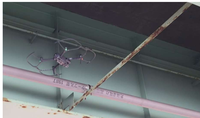
橋梁に施設したケーブル点検
