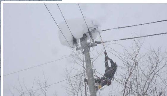
除雪作業の様子
