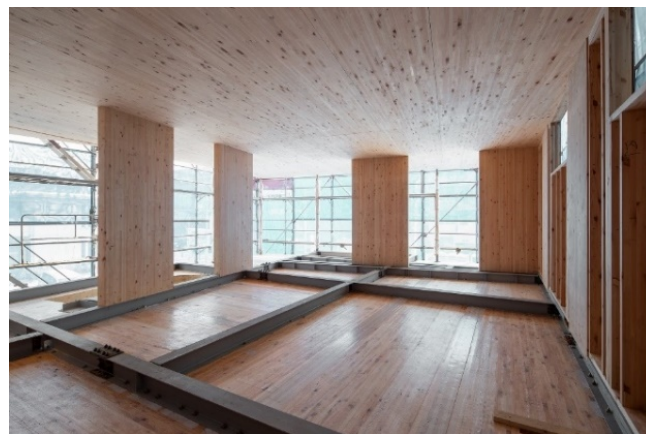
【「FMT 構法」の施工現場】
