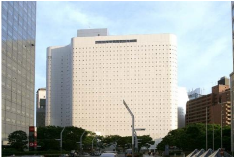
新宿ワシントンホテル (本館)
