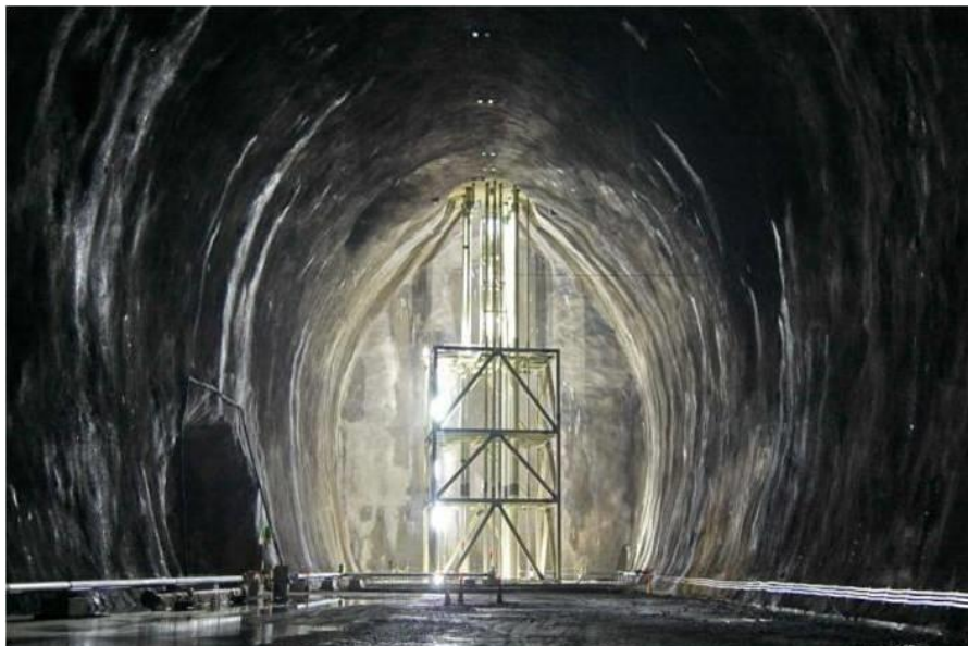
地下岩盤貯槽 長さ:(485メートル)×2列、(430メートル)×1列
