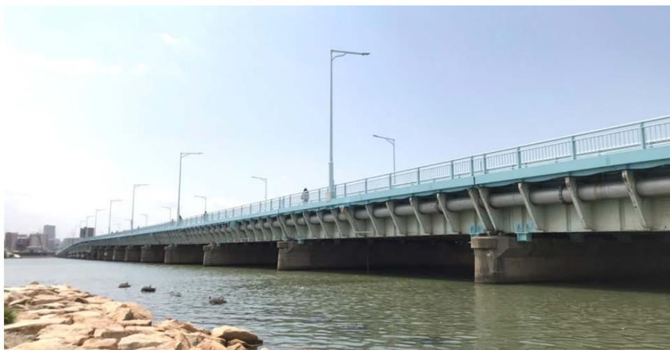
写真 CORSPACE 適用橋梁一例：国道2号淀川大橋（床版取替他工事後写真）／発注者：国土交通省 近畿地方整備局殿
