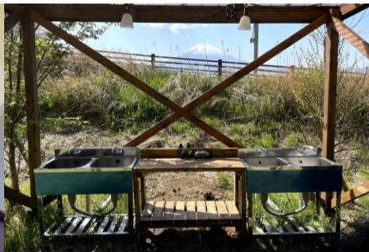
炊事場は2シンクを2台設置
