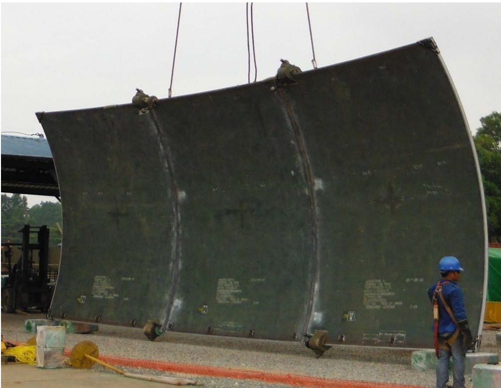
泉北第一工場 5 号タンクに使用される 7%ニッケル鋼板
