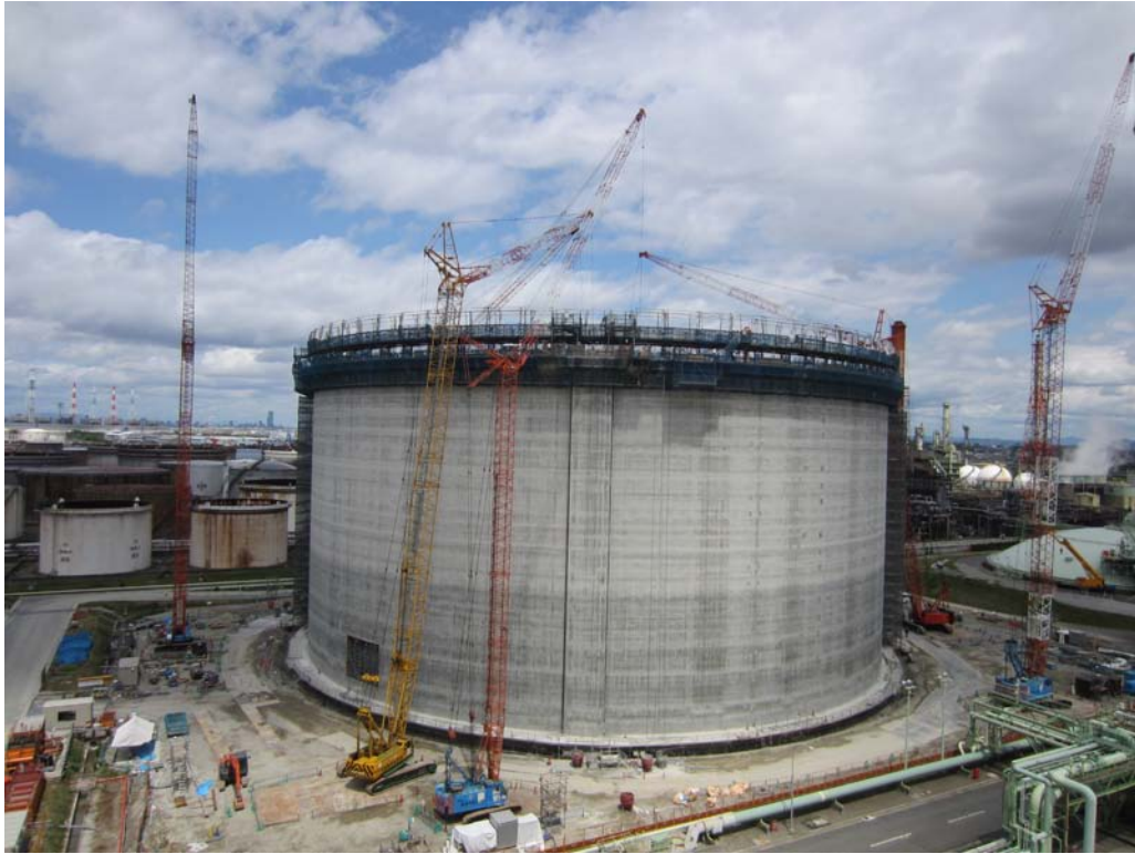
建設中の泉北第一工場 5 号タンク
