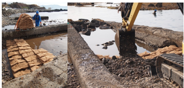
ビバリー®ユニットの埋設状況
