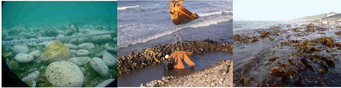
適用前の海底の状況 ビバリー®ユニットの施工 藻場の再生（コンブが繁茂）
