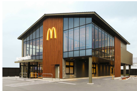
国産木材を使った「マクドナルド 五条桂店」 ロゴ周囲などの外壁装飾に国産木材を使用
