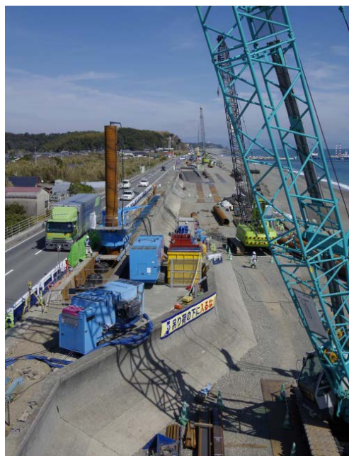
写真2 高知海岸施工状況
