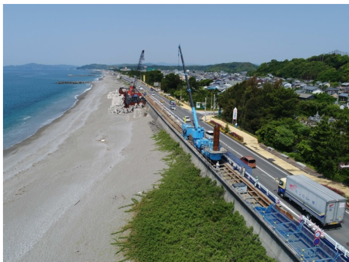
写真1 高知海岸施工状況
