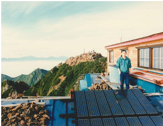
1986年、NEDOの実証事業として八ヶ岳の最高峰赤岳の山荘に太陽光発電システムを設置
