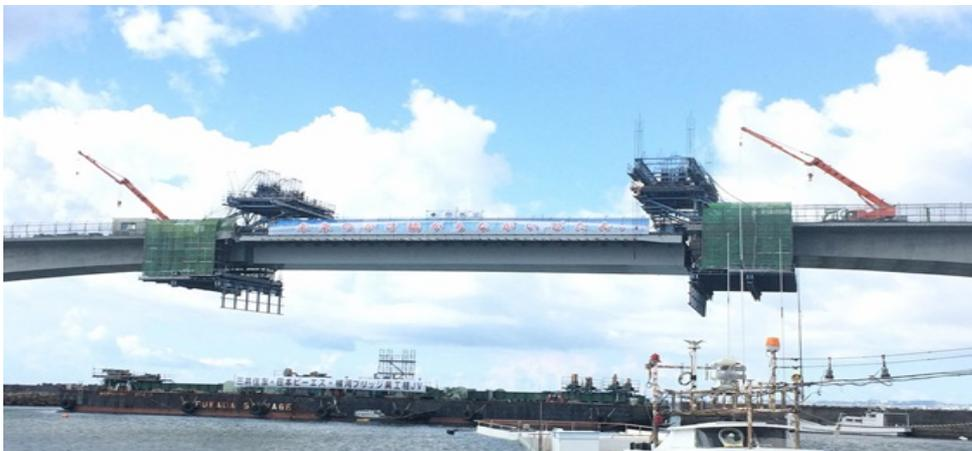
写真 「牧港高架橋」 鋼橋部一括架設状況写真
