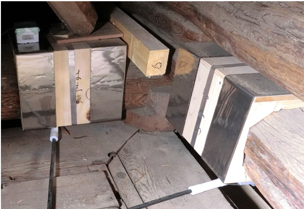
チタン箱の施工の様子
