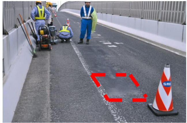
3M™ ステイマーク™ 路面補修材 L715を施工した路面
