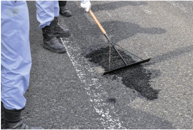
路面上にできたポットホールの補修作業
