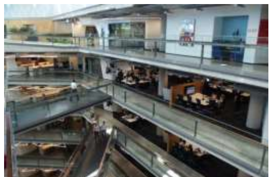
社内各部署を階段とブリッジで繋ぎコミュニケーションを向上 (ナショナルオーストラリア銀行/メルボルン)
