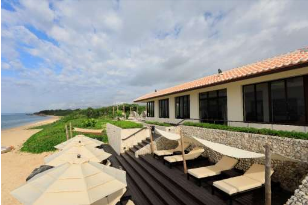
「ビーチハウス」外観
