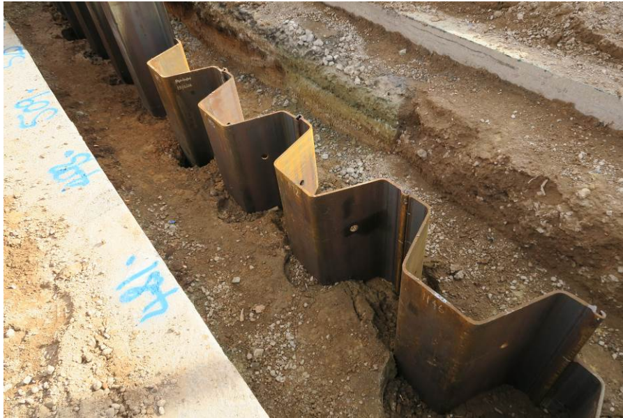
写真 5. オーストラリアの市街地におけるハット形鋼矢板の打設後の状況
