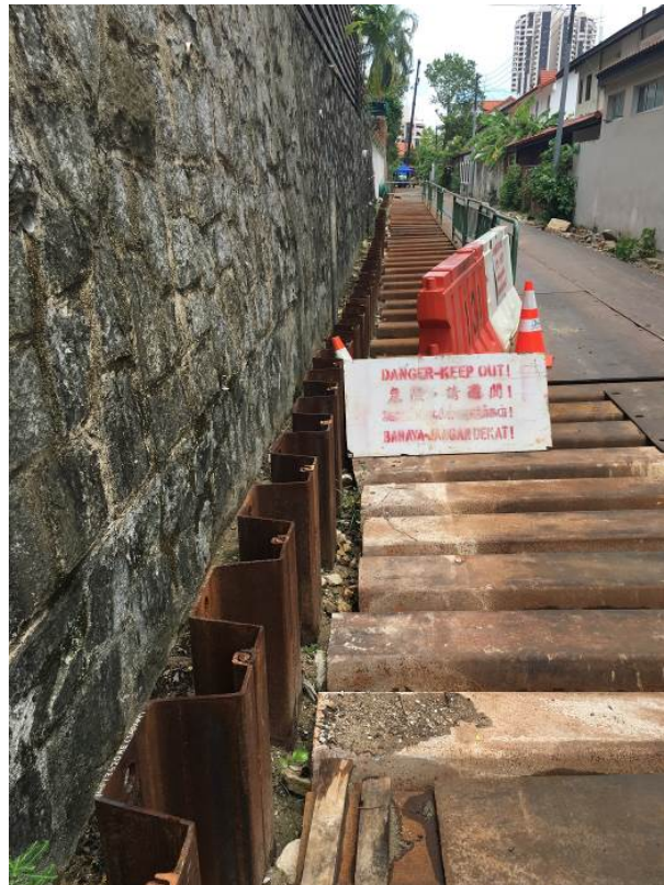
写真4. シンガポールの住宅地内におけるNS-SP-Jの打設後の状況
