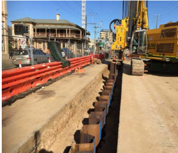
写真3. オーストラリアの市街地におけるハット形鋼矢板の打設状況（2）
