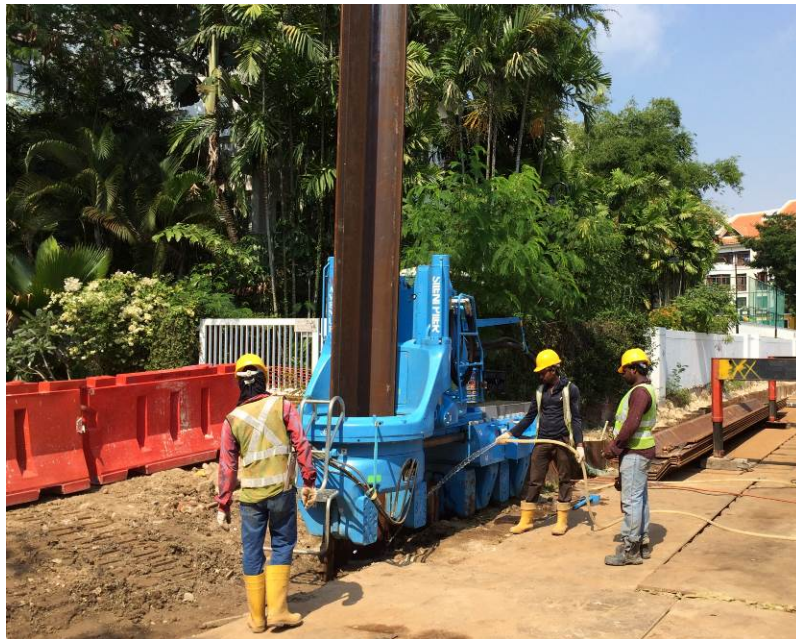
写真 1. シンガポールの住宅地内におけるハット形鋼矢板の打設状況
