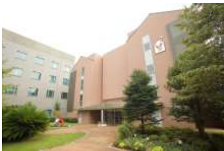
日本第一号「せたがやハウス」外観
