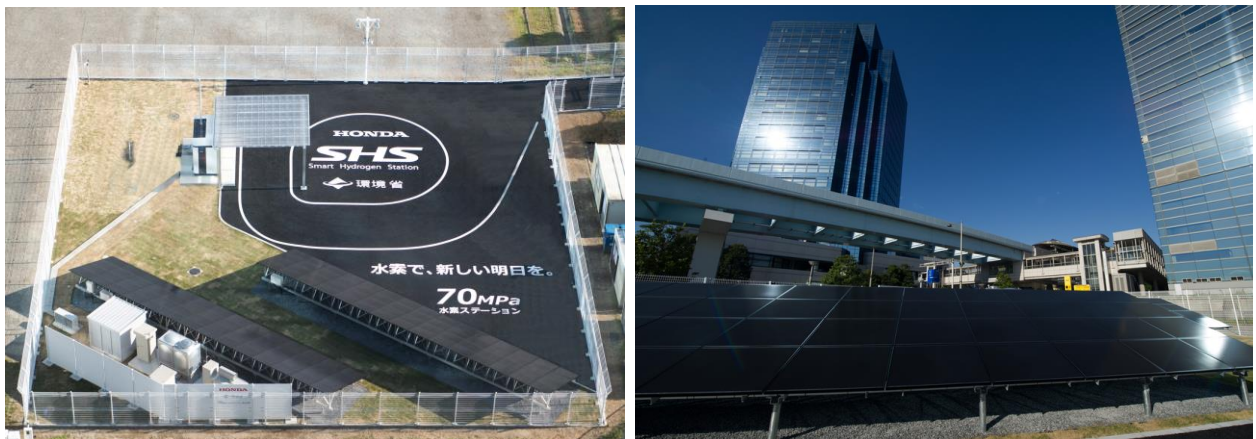
「70MPa スマート水素ステーション」に設置したソーラーフロンティアのCIS 薄膜太陽電池
