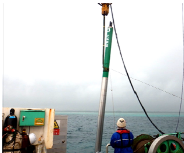
小浜航路第三号灯標の設置の様子
