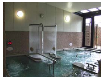
ジャグジーのある女性用浴室 (御嵩花トピアコース)
