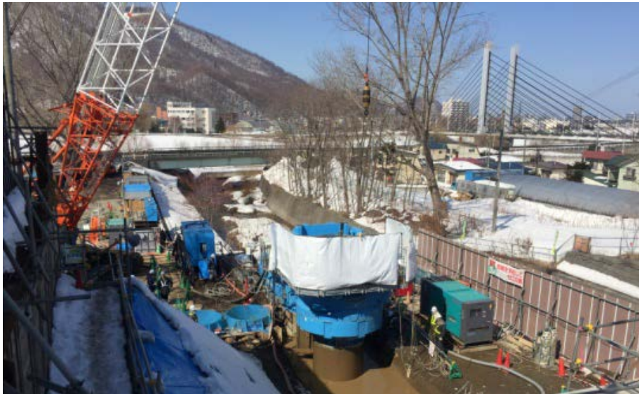
写真4 施工状況(上流左岸側より)
