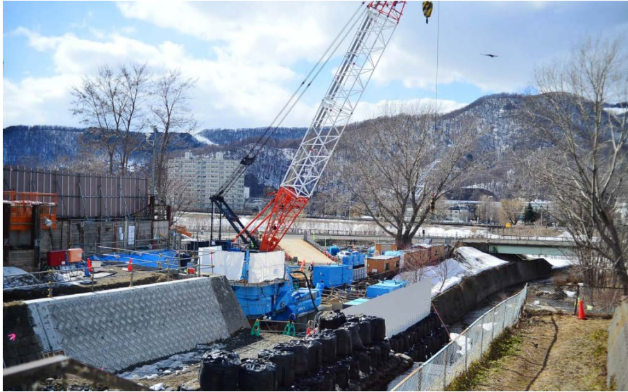
写真3 施工状況(上流右岸側より)
