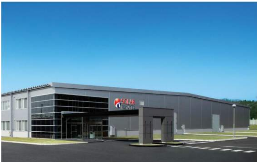
東北工場の外観
