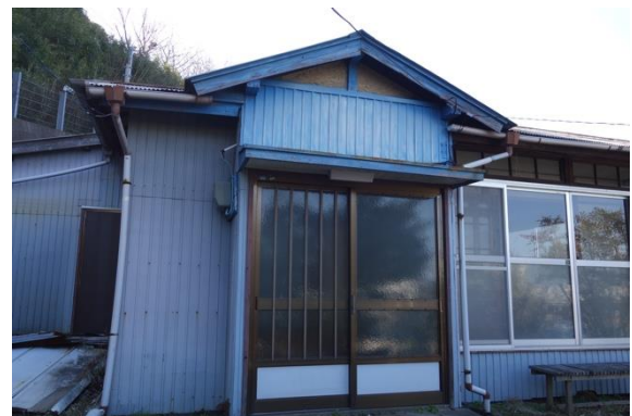
改修中の平屋建て住宅の外観
