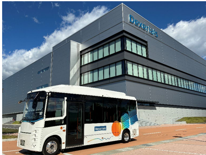
稼働を開始した EV バスと鹿沼事業所第 2 工場の新棟
