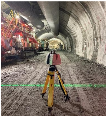
写真 2：レーザースキャナによる点群計測
