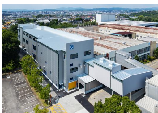
新設した G 棟
