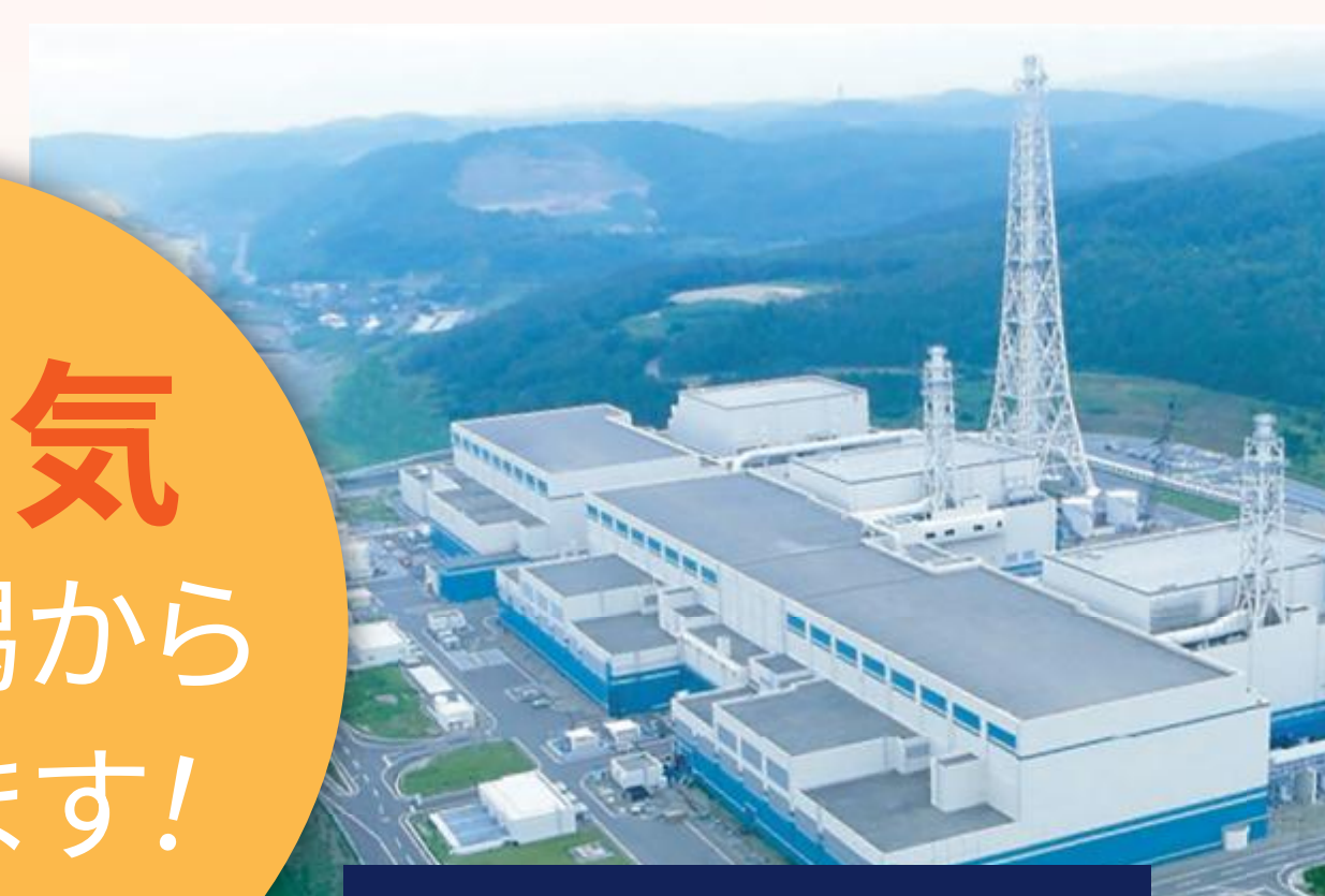
柏崎刈羽原子力発電所
