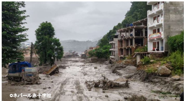
洪水により住宅やインフラに深刻な被害が生じたヌワコット郡
