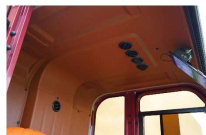
(天井と背面の送風口)
